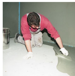
4. ... oder der zementären Sicherheits-Dichtschlämme PCI Seccoral auftragen.
