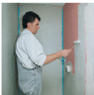
3. Nach Trocknung der PCI Wadian-Spezialgrundierung können Flächen mit der wasserdichten, flexiblen Schutzschicht PCI Lastogum ...
