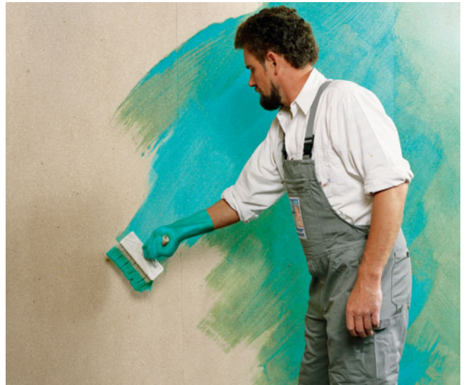
PCI Wadian als Wasserdampf bremsende Grundierung auf Holzspanplatten vor der Fliesenverlegung.
