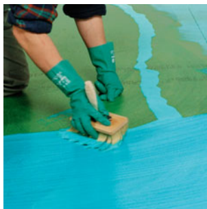
2. Nach einer Ablüfzeit von ca. 30 Minuten zweiten Anstrich oberflächendicht aufbringen.
