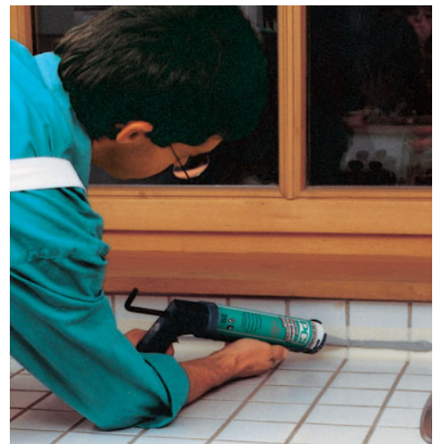
Elastisches Schließen der Eck- und Anschlussfugen des Fliesenbelages auf einer Küchenarbeitsplatte.
