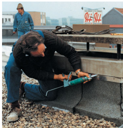
Elastisches Schließen von Anschlussfugen an einem Kamin zwischen Beton und Edelstahlverwahrung.
