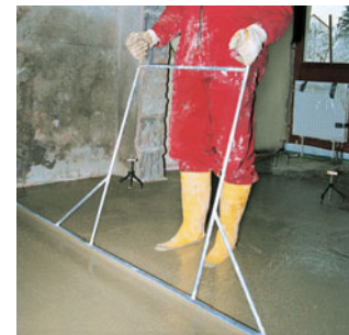
... Mörtel verteilen und mit Schwabbelstange überarbeiten.
