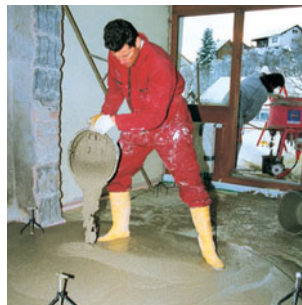
PCI Periplan plus auf Trennlage oder auf die getrocknete, ausgehärtete Grundierung ausgießen ...
