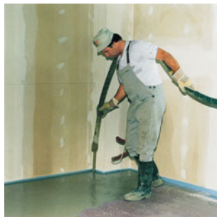
Bei größeren Flächen wird PCI Periplan plus rationell im Pumpverfahren aufgebracht.
