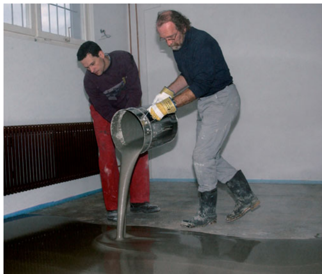
Rationeller und wirtschaftlicher Bodenausgleich mit PCI Periplan vor dem Verlegen von Oberbelägen.
