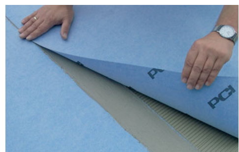
Innerhalb der klebeoffenen Zeit die folgende Bahn einlegen.
