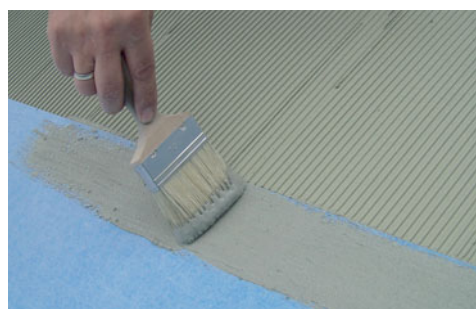
Zum wasserdichten Verkleben der Stöße PCI Seccoral 1K/2K fehlstellenfrei auf die PCI Pecilastic-W-Bahn aufbringen.
