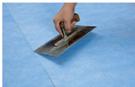
Bahnen mit Traufel, Gummiwalze oder Klopfbrett andrücken.
