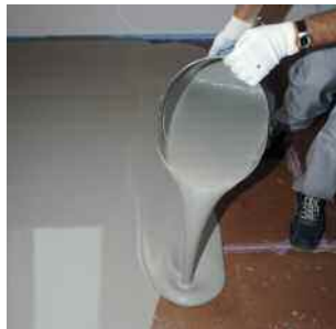
PCI Nanosilent wird einfach auf den Untergrund ausgegossen,...
