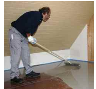
und mit einer Stachelwalze entlüftet.
