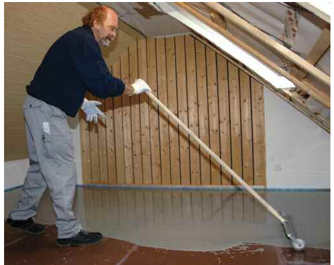
Mit PCI Nanosilent können Untergründe in einem Arbeitsgang trittschallreduzierend und entkoppelnd ausgeglichen werden.
