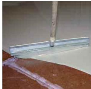
mit einer geeigneten Rakel in der erforderlichen Schichtdicke verteilt...
