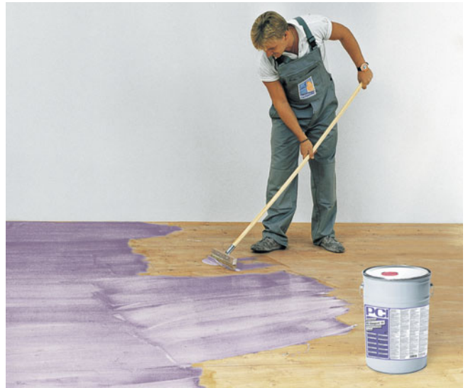
PCI Gisogrund 404 in der Kontrollfarbe violett ermöglicht eine hohe Verbundhaftfestigkeit von Ausgleichsmassen und Verlegewerkstoffen zum jeweiligen Untergrund.
