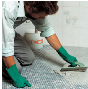
PCI-Fugenmörtel mit Gummifug- scheibe bündig in die Fugen ein- bringen.
