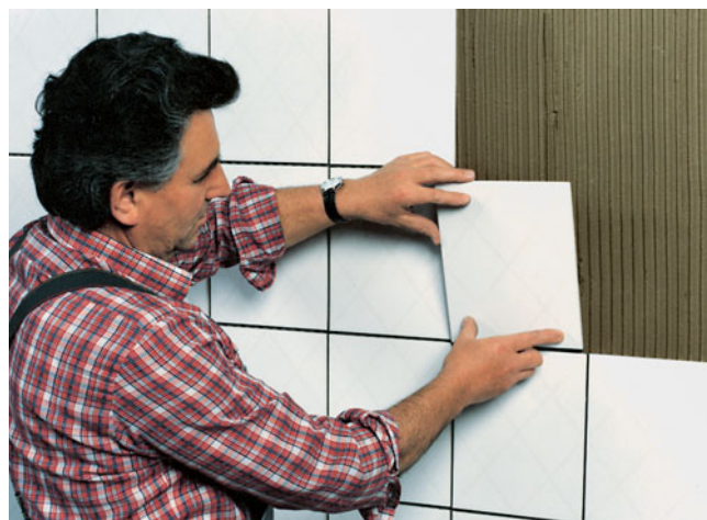
Funktionssichere Plattenverlegung im Dünnbettverfahren mit PCI FT-Klebemörtel.
