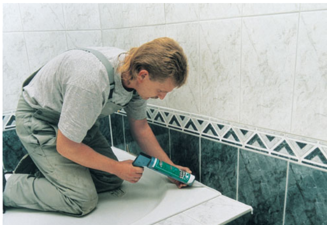
Eck-, Anschluss- und Bewegungsfugen elastisch schließen.
