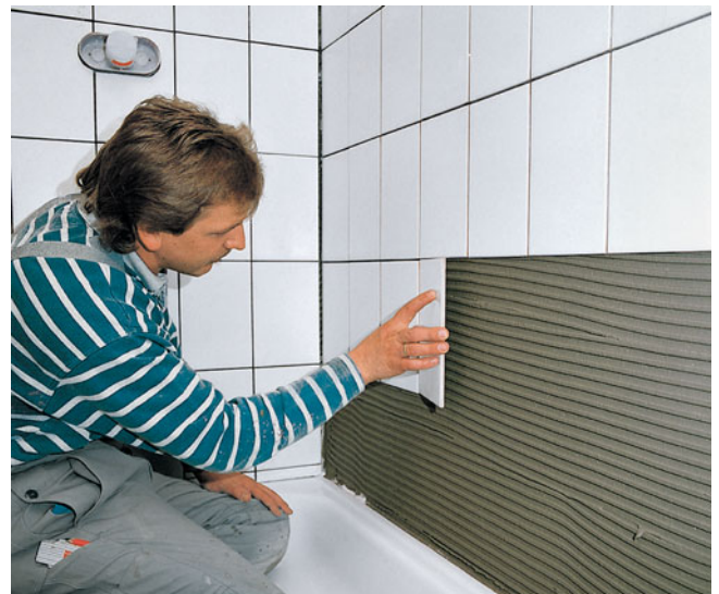
Mit PCI FT-Extra können Steingutfliesen auf der alternativen Abdichtung PCI Lastogum sicher verlegt werden.
