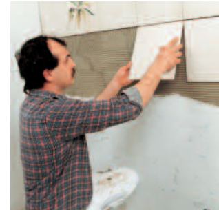
Mit PCI Flexmörtel und PCI Flexmörtel-Schnell können Fliesen und Platten auf verformungsfähigen Untergründen, z. B. Betonfertigteilen, verlegt werden.
