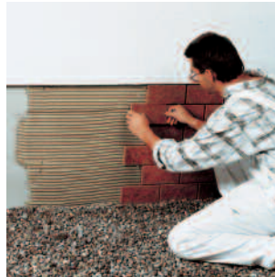
Verlegen keramischer Platten mit PCI Flexmörtel/PCI Flexmörtel-Schnell im Sockelbereich an Gebäuden.
