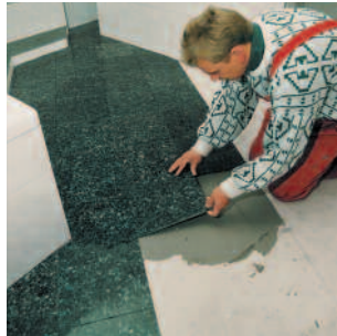
Mit PCI Flexmörtel und PCI Flexmörtel-Schnell können keramische Platten sicher auf Zementestrichen verlegt werden.
