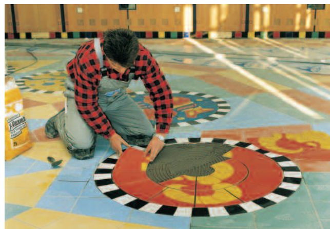
Mit PCI Flexmörtel und PCI Flexmörtel-Schnell können Fliesen und Platten sicher verlegt werden.
