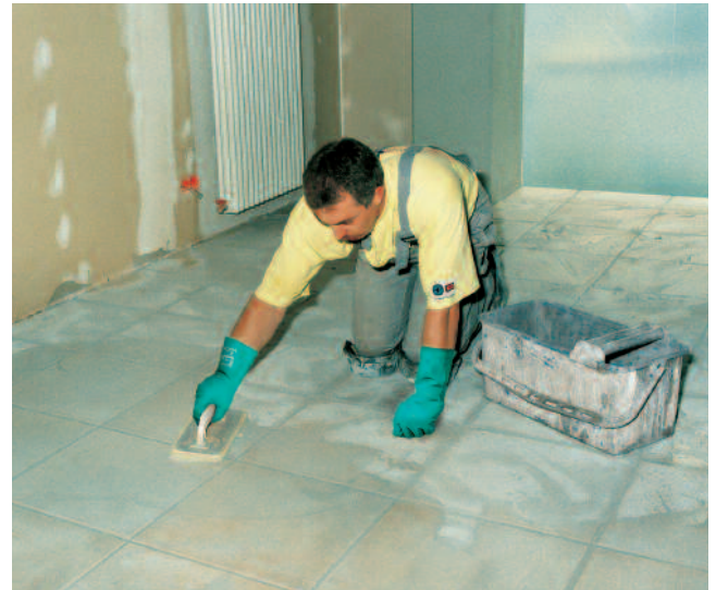
Mit PCI Flexfug können Fugen von 2 bis 10 mm bzw. von 3 bis 15 mm (abhängig vom Farbton) rissefrei verfugt werden.
