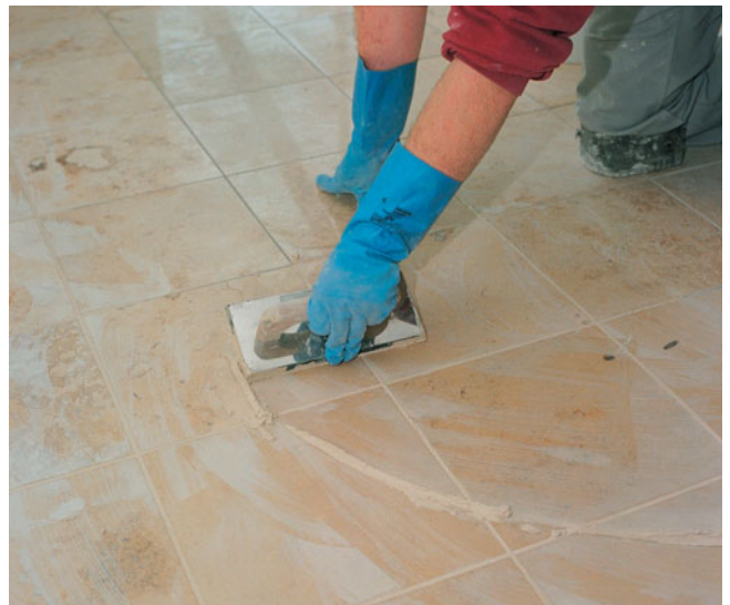
Mit PCI Carrafug können auch empfindliche Naturwerksteinbeläge sicher und verfärbungsfrei verfugt werden.
