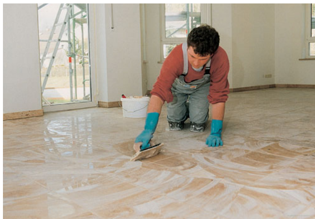
Naturwerksteinplatten mit dem Spezial-Fugenmörtel PCI Carrafug verfugen und Boden- und Wandanschlussfugen im System mit dem Silikon-Dichtstoff PCI Carraferm schließen.
