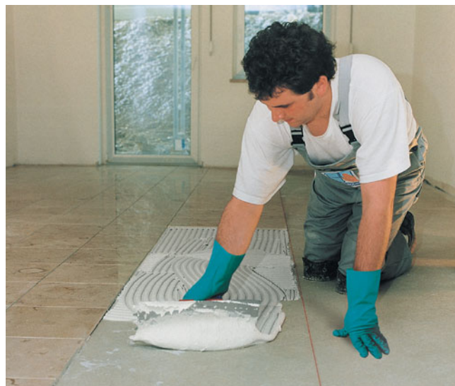
Mit dem weißen Verlegemörtel PCI Carrablott können auch durchscheinende Naturwerksteinplatten sicher verlegt werden.
